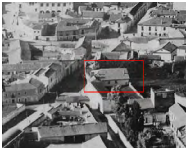
Edificio del antiguo palacio de los Meneses de donde creemos que proceden las vigas estudiadas. Foto aérea, c.1962.
