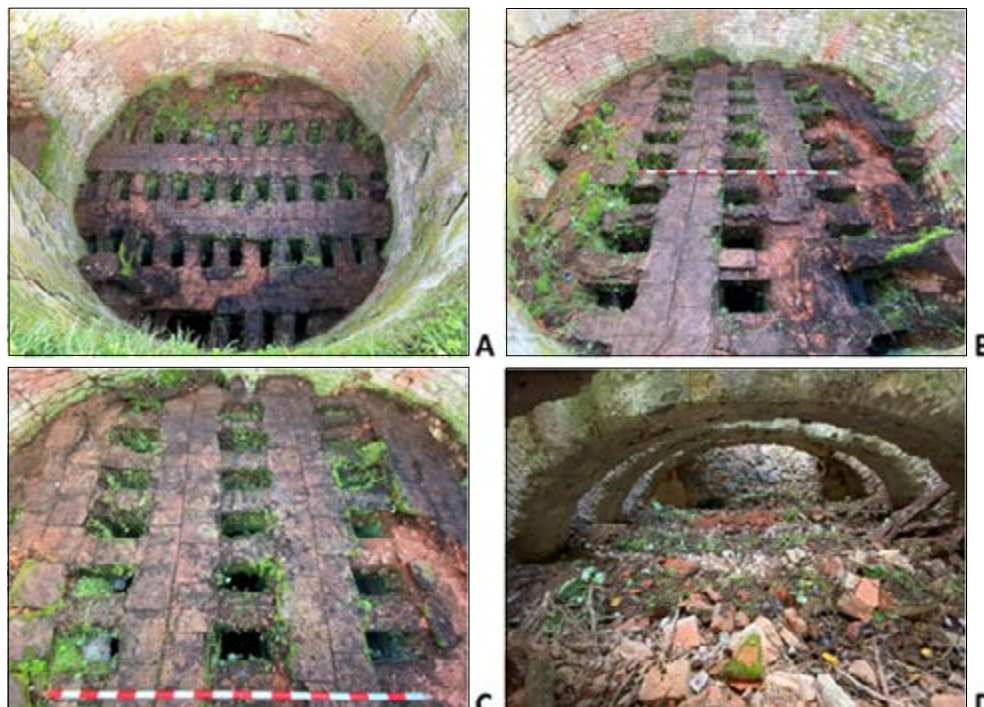
Fig. 6. A-C: Vistas de la parrilla; D: Vista de la cámara de combustión (Autores)
