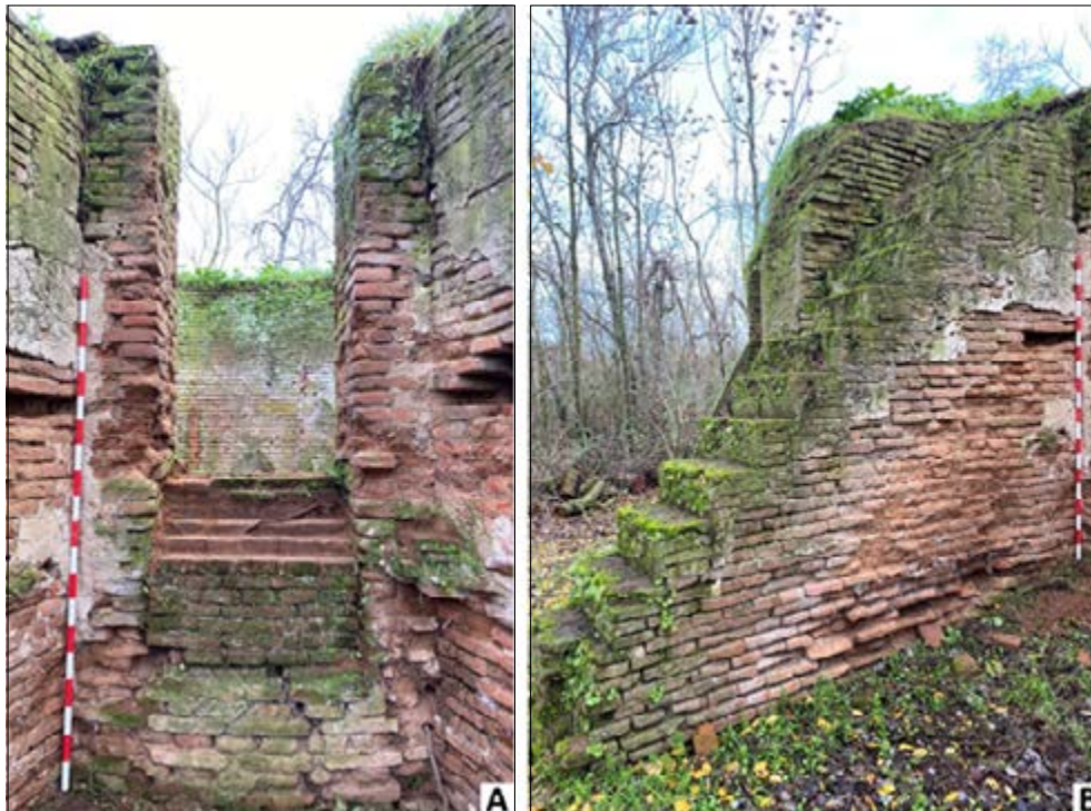
Fig. 7. A: Vano del cargadero y B: Antepecho escalonado junto a la zona de carga (Autores)
