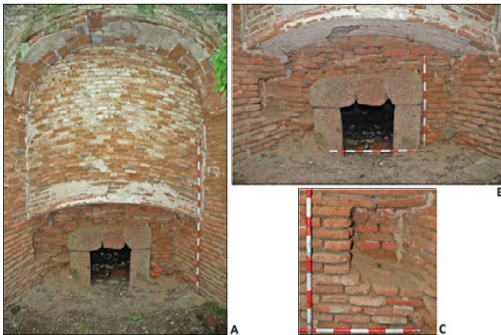
Fig. 8. A: Vista general de la cámara de combustión; B: Detalle del vano de acceso a la cámara de combustión y C: Detalle de la hornacina (Autores)
