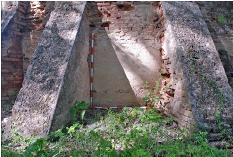
Fig. 9. Detalle de los contrafuertes (Autores)
